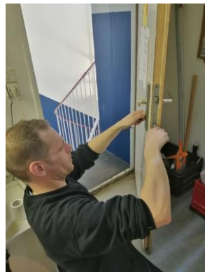
Ein Zylinder wird getauscht
